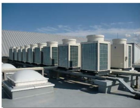
▲ 富士 OGMGC 小野コースへ導入したビル用マルチエアコン室外機（左）とヒートポンプ給湯器（右）
