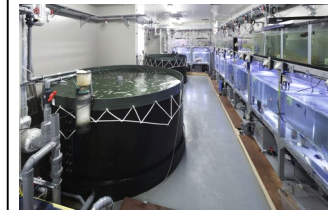
予備水槽室(バックヤード)
