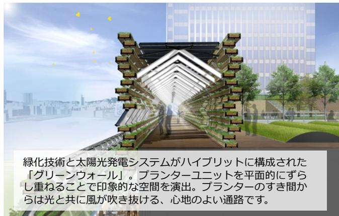
緑化技術と太陽光発電システムがハイブリットに構成された「グリーンウォール」。プランターユニットを平面的にずらし重ねることで印象的な空間を演出。プランターのすき間からは光と共に風が吹き抜ける、心地のよい通路です。
