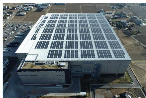
太陽光発電システムを設置
