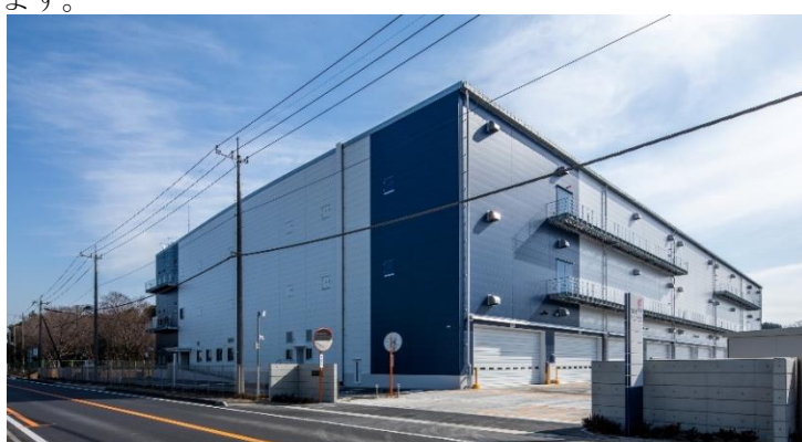
「守谷Ⅱロジスティクスセンター」外観
