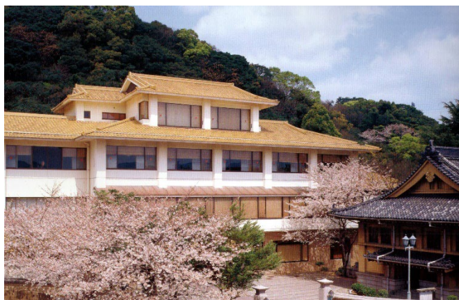
下関春帆楼本店 外観
