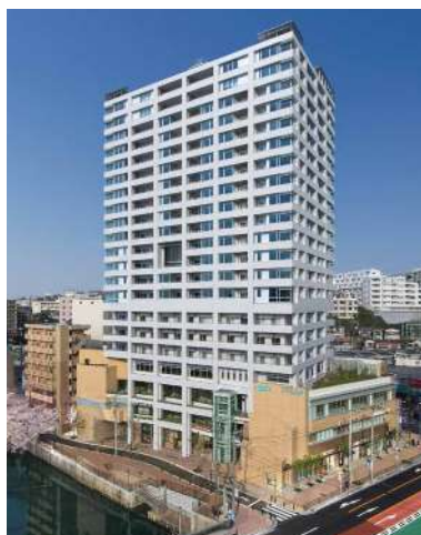
ザ・スカイクルーズタワー【日ノ出町駅前A地区】
